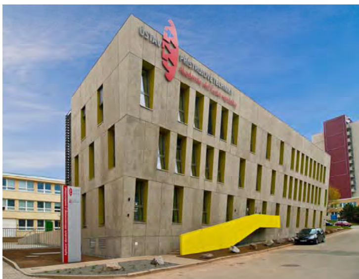
Nová budova ALISI
